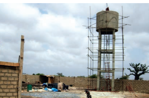
Le château d'eau de Soussane en construction.
