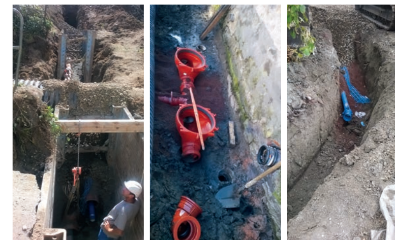
Reprise de l'ensemble des réseaux de la rue de Planchepaleuil.
