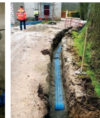
Pose de canalisations.
