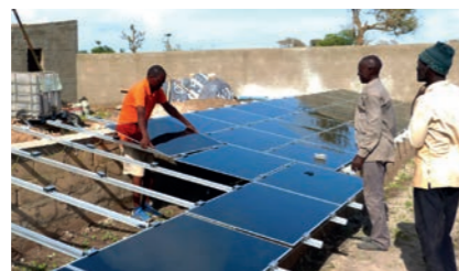
La pose de panneaux solaires à Louly Sindiane.
