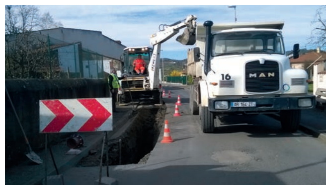
Chantier SEMERAP – Remplacement de conduite sur la commune de Bouzel.
