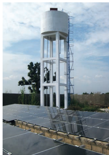
Le château d'eau achevé.
