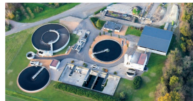
Vue aérienne de la station d'épuration de Pont-du-Château.
