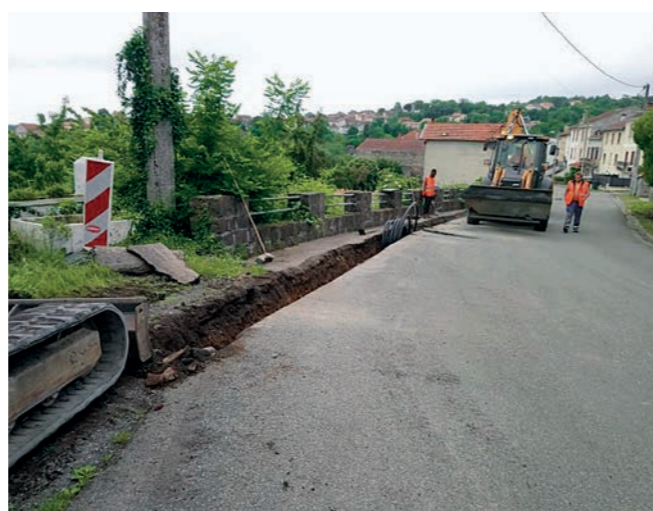
Travaux de Saint-Bonnet-près-Riom, rue de Parmentier.
