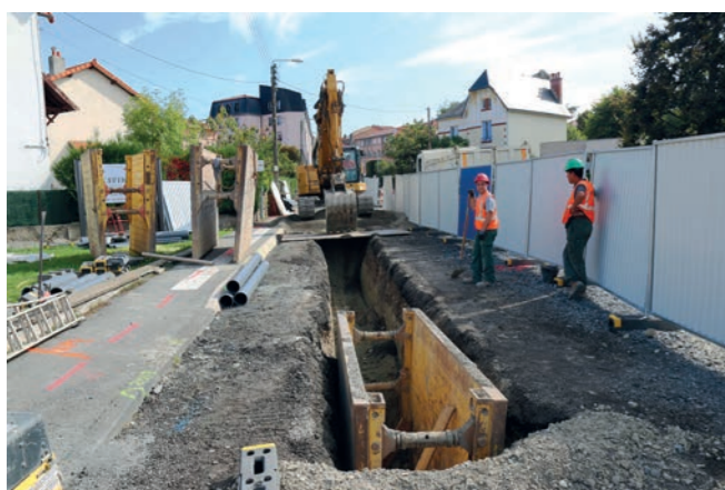
Travaux sur l'avenue de Châtel-Guyon.
