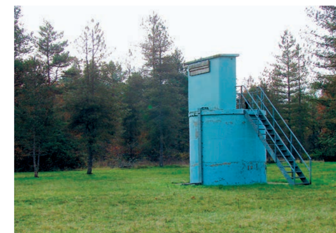
Puits de captage Bec de Dore.
