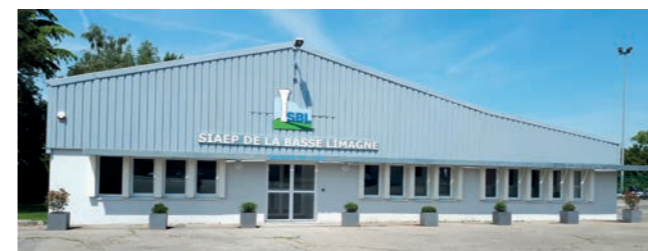
Nouveaux locaux du SIAEP.
