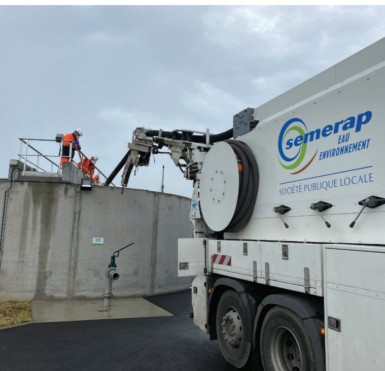
Entretien d'un bassin d'épuration.
