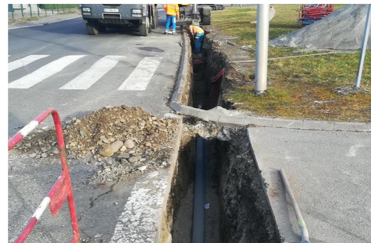
Travaux 2020 à Ennezat, rue du Docteur Bassin (Source Egis-Eau).
