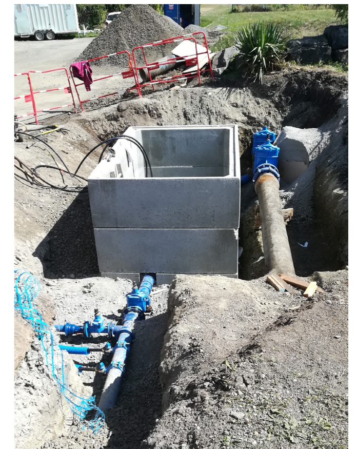
Travaux 2020 à Ménétréol Rue des Charmes (source Egis-Eau).
