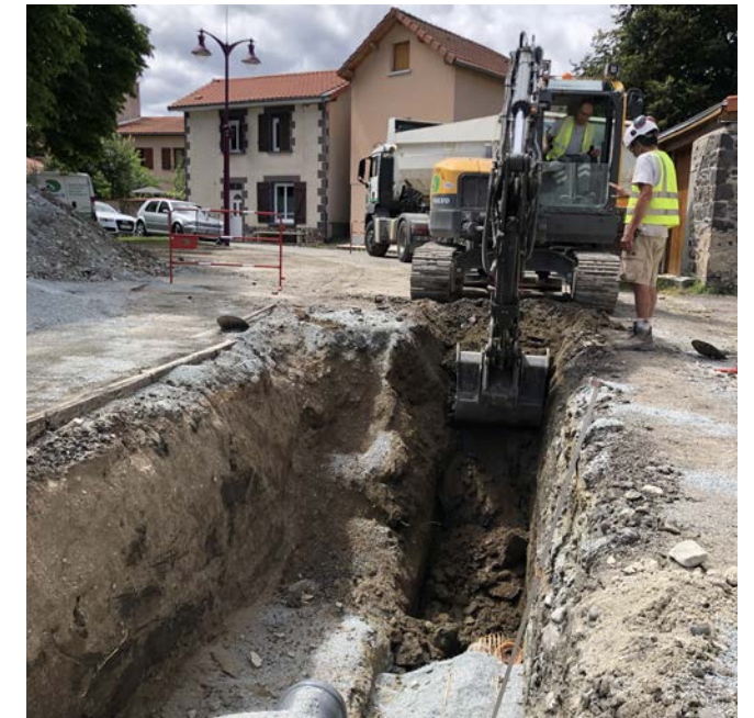
Travaux d'eaux pluviales, rue Sainfoin à Malintrat.
