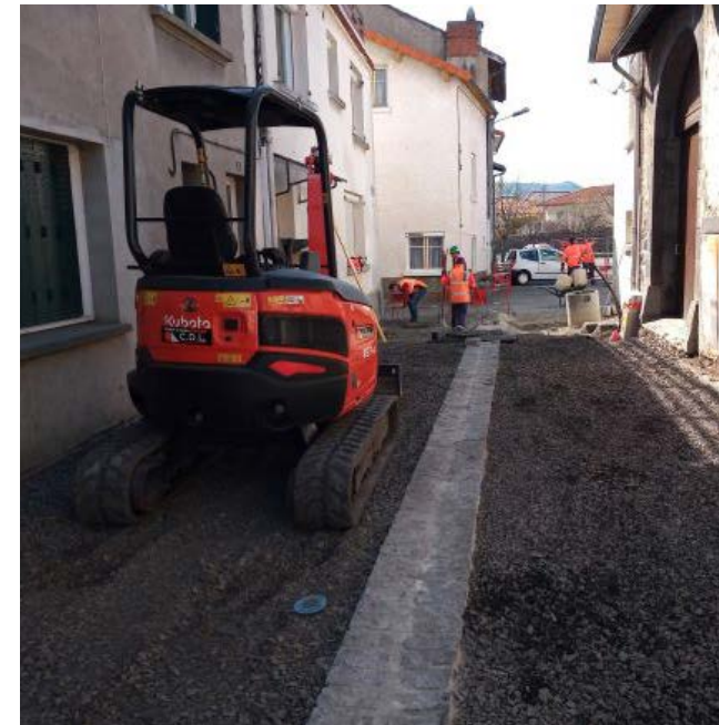
Travaux d'eau potable et d'assainissement, rue Louis Pasteur à Mozac.
