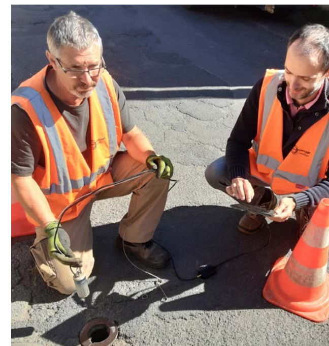
Pose de prélocalisateurs dans une bouche à clé.
