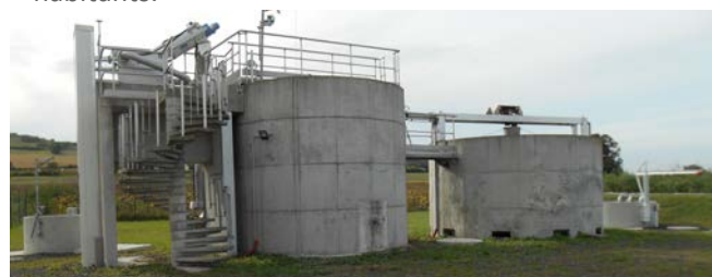
Station d'épuration de Vassel.
