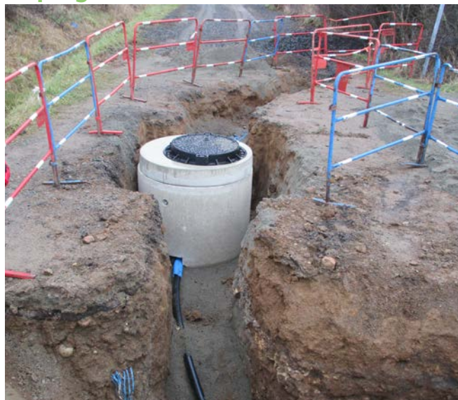
Travaux Châtel-Guyon - rue des Crozets
