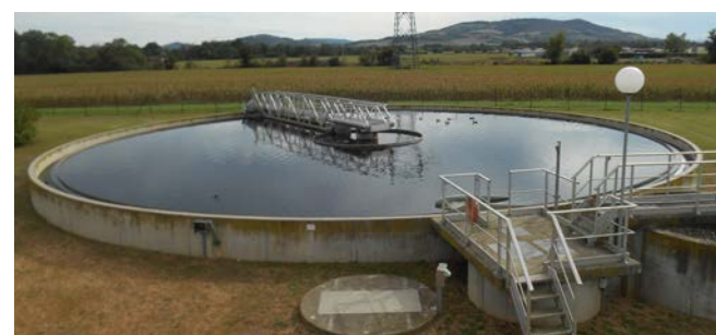
Clarificateur de la station des Madeleines à Pont-du-Château.
