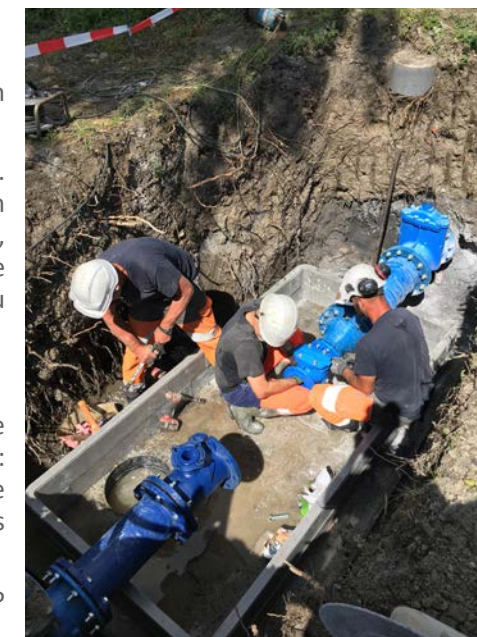
Travaux de réhabilitation d'un regard de régulation sur la commune de Cébazat.
