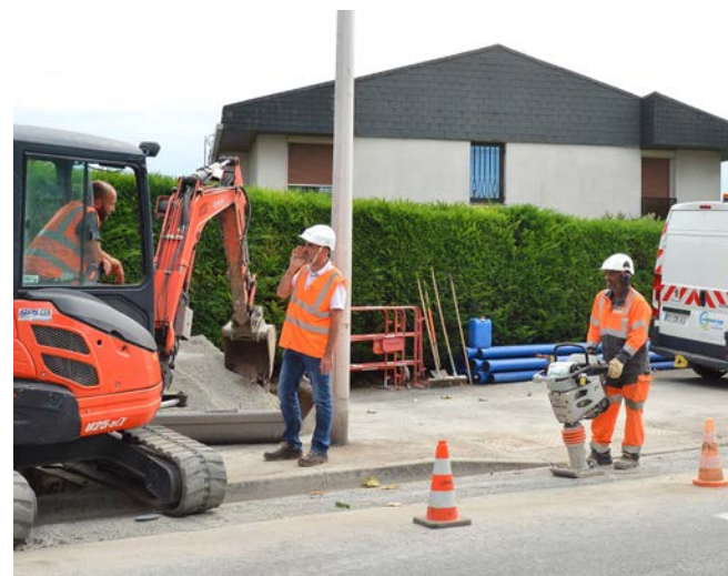
Travaux de raccordement sur la commune de Gerzat.
