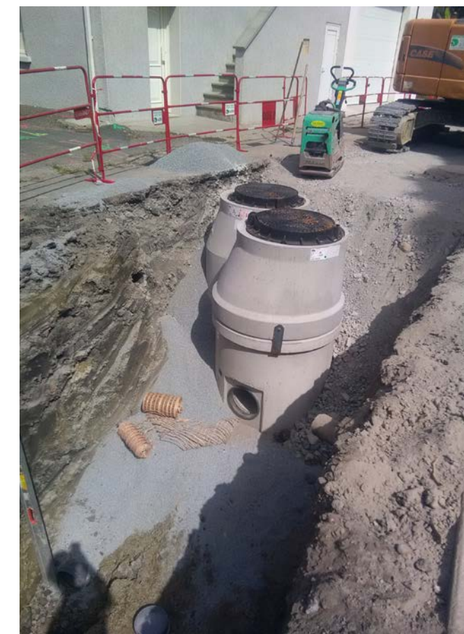
Chantier rue du Sainfoin à Malintrat.
