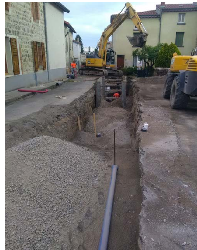
Chantier du bourg à Bouzel.
