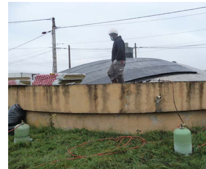
Restauration du dôme du réservoir de Châteaugay.
